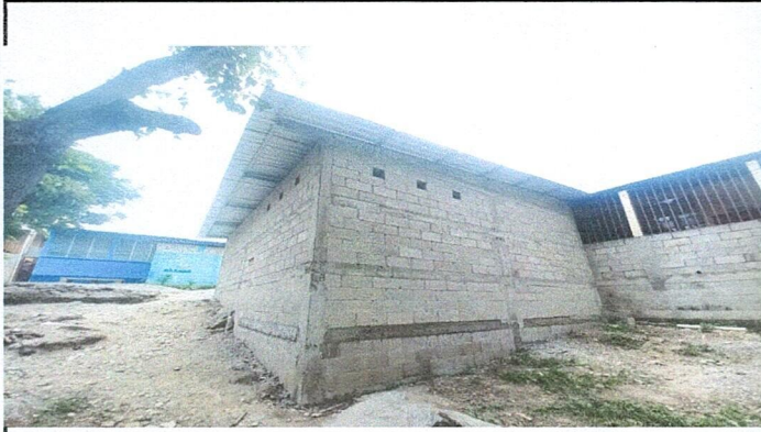
Foto 1: ÁREA DONDE SE REALIZÓ EL MEJORAMIENTO DE COCINA.
